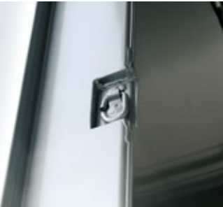
5 骨格側面G型フック1対埋め込み
