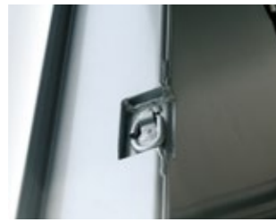
5 骨格側面G型フック1対埋め込み
