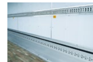
ウイング部ラッシングレール
