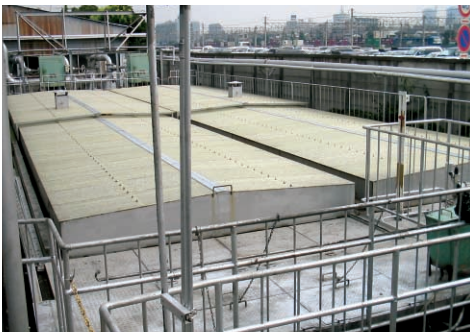
排水処理槽カバー
