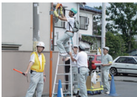
カーブミラー清掃作業
