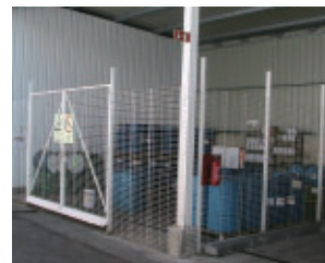
施錠された溶剤保管場所
