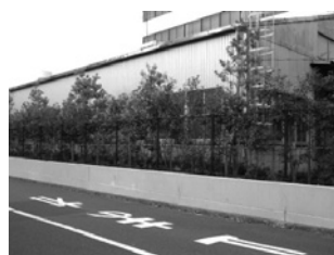
コンクリート塀をネットフェンス化した例
