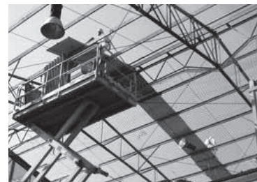
繊維セメント製屋根の交換
