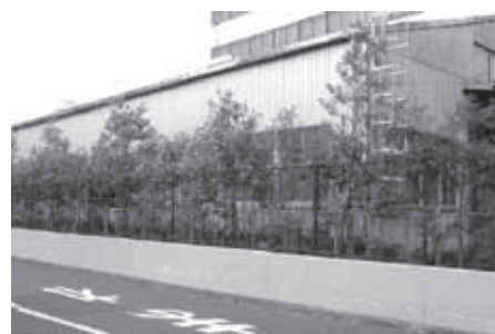
コンクリート塀のネットフェンス化
