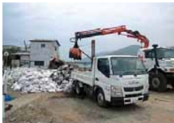
ゼトロスとキャンターが2台で協力して作業 (宮城県石巻市)
