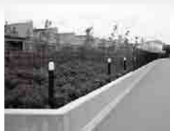
コンクリート塀のネットフェンス化
