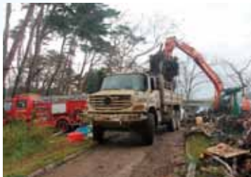
瓦礫を積み込む岩手県山田町のゼトロス
