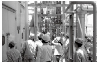
コージェネレーション発電設備見学の様子
