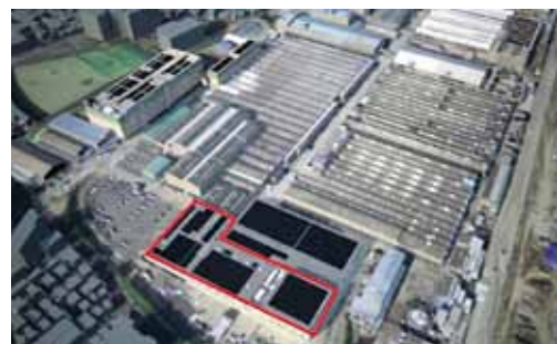
太陽光発電設備導入予定部分（2014年1月完成予定）
