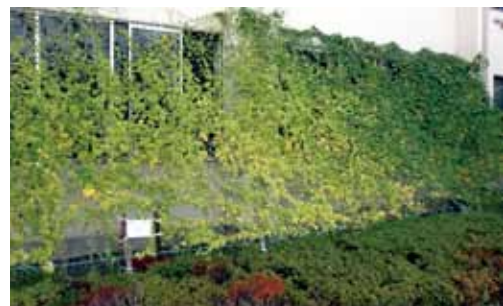
ゴーヤによるグリーンカーテン（川崎製作所）
