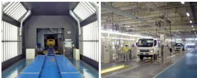
塗装工場に導入されたLED照明（川崎製作所） 整備工場に導入されたLED照明（帯広支店）
