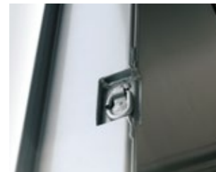
5 骨格側面G型フック1対埋込み
