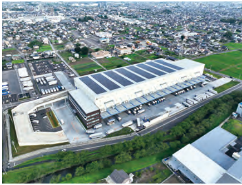
名鉄トラックターミナル中部では、太陽光パネルの他、地下水を利用した膜ろ過システムの導入など、先進的な取り組みを行っている。
